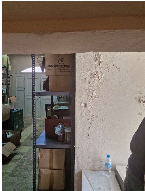
Εικόνα 19. ΟΙ ΥΓΡΑΣΙΕΣ ΠΛΗΣΙΟΝ ΤΟΥ ΠΑΡΑΘΥΡΟΥ ΤΗΣ ΑΠΟΘΗΚΗΣ
