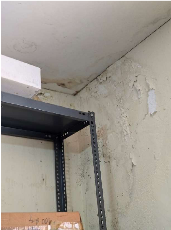
Εικόνα 18. ΥΓΡΑΣΙΕΣ ΣΤΗΝ ΑΠΟΘΗΚΗ
